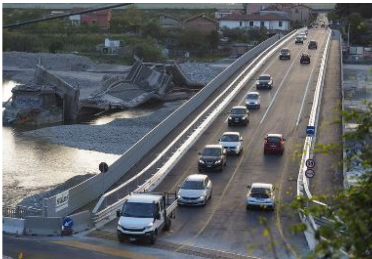
Il nuovo ponte di Albiano Magra ora aperto al traffico dopo il lungo cantiere
